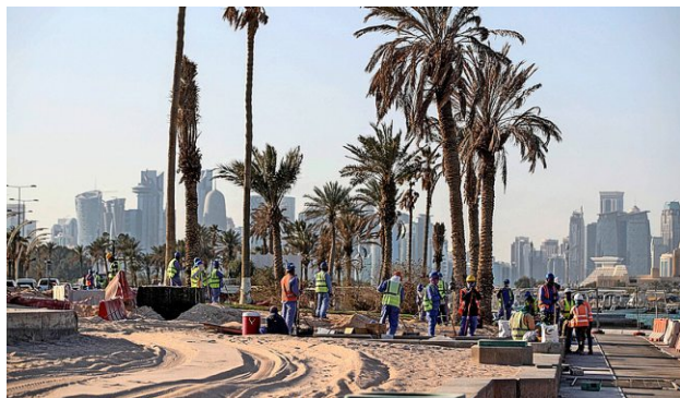
Arbeiter in Doha auf einer Baustelle für die Fussball-WM. IMAGO
